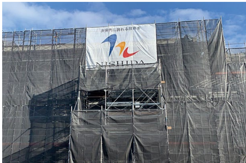
チームの意見を採用して導入したメッシュシート。現場内の明るさや、強風時の足場倒壊などのリスク対策になる。
